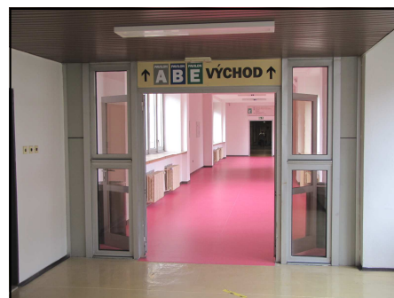
Chodba E—D je již hotová. FOTO: nk
